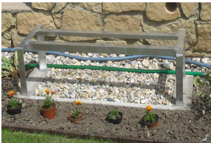
Afbeelding 8: Voorbeeld van een basisuitvoering voor een warmtepomp
